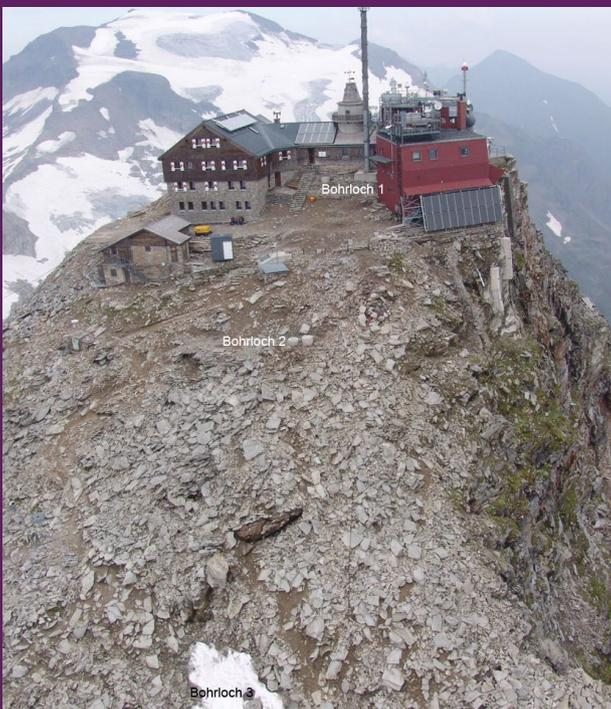
Das Observatorium Hoher Sonnblick der ZAMG steht auf Permafrost. Dieser wird mit den eingezeichneten Bohrlöchern überwacht.
